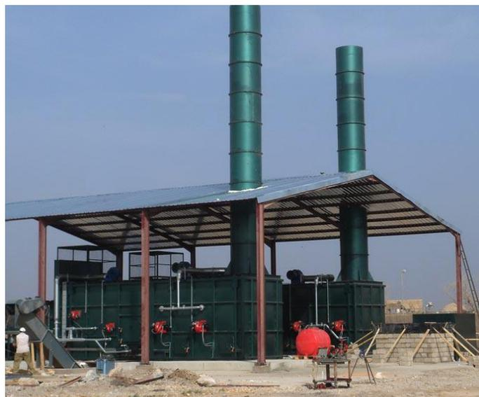
**Photo 1. Incinérateur à deux chambres de combustion.**
